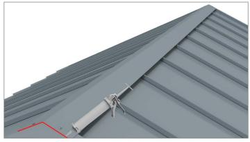
เก็บรายละเอียด ซีลรอยต่อทุกจุดหรือบริเวณที่มีรูทุกรูให้เรียบร้อยด้วยซิลิโคน ที่กำหนดให้โดยอาควาไลน์ หรือซิลิโคนอะคริลิค 100 % ห้ามใช้ซิลิโคนซีลกระจก หรือซิลิโคนที่มีกรด ที่จะมีผลทำให้เกิดการกัดกร่อนกับแผ่นหลังคาและไม่มีประสิทธิภาพ
